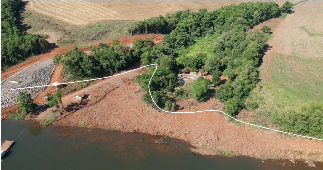
Figura 8-3 - Local proposto para a ZLAC na margem direita. Verifica-se que é um local arborizado, de fácil acesso e ao lado da ponte em construção.
