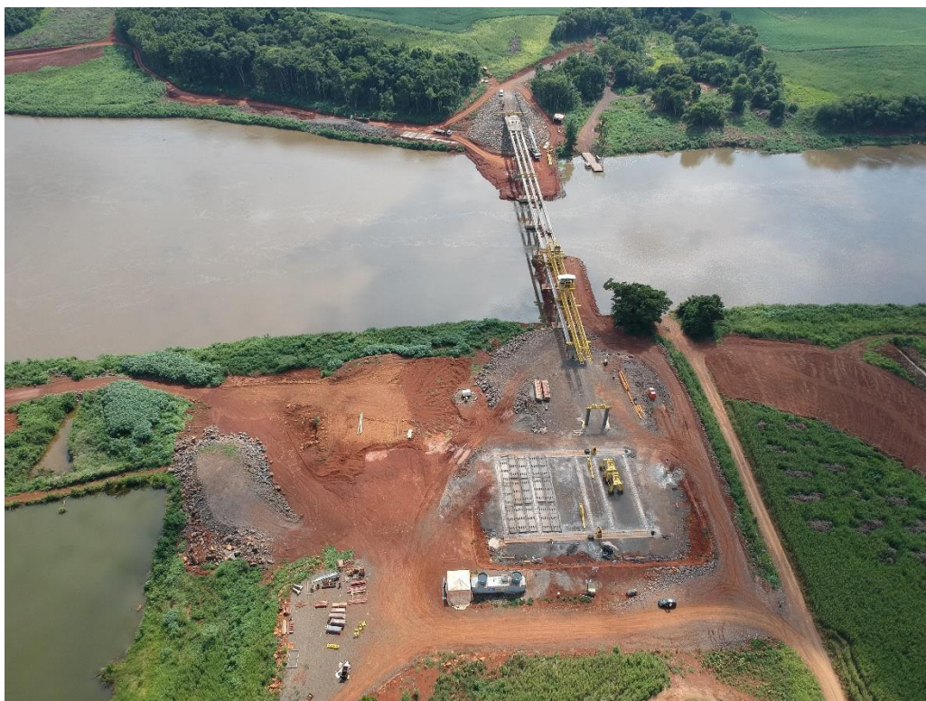
Figura 10-8 - Acesso à ponte pela margem esquerda (primeiro plano).
