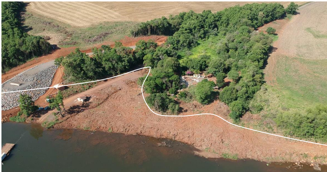
Figura 10-4 - Local proposto para a ZLAC na margem direita. Verifica-se que é um local arborizado, de fácil acesso e ao lado da ponte em construção. Linha branca é a projeção da cota do reservatório.
