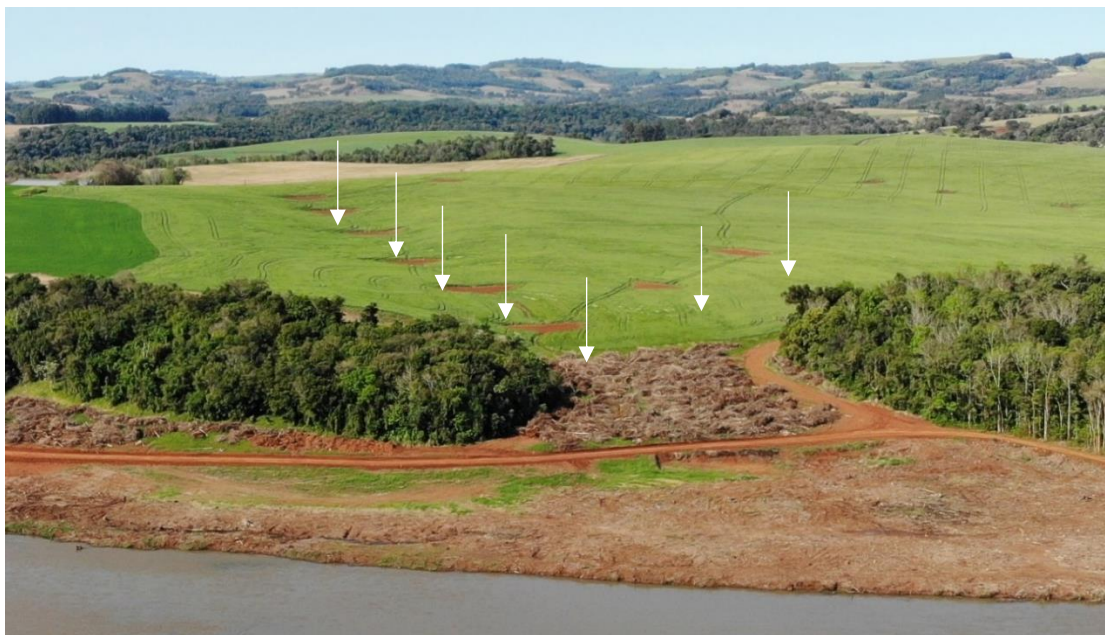
Figura 6-26 - Fluxo erosivo interceptado através da utilização dos bacias/terraços de contenção ao longo da vertente na propriedade limdeira à APP, e galhada proveniente da supressão, em agosto de 2020.
