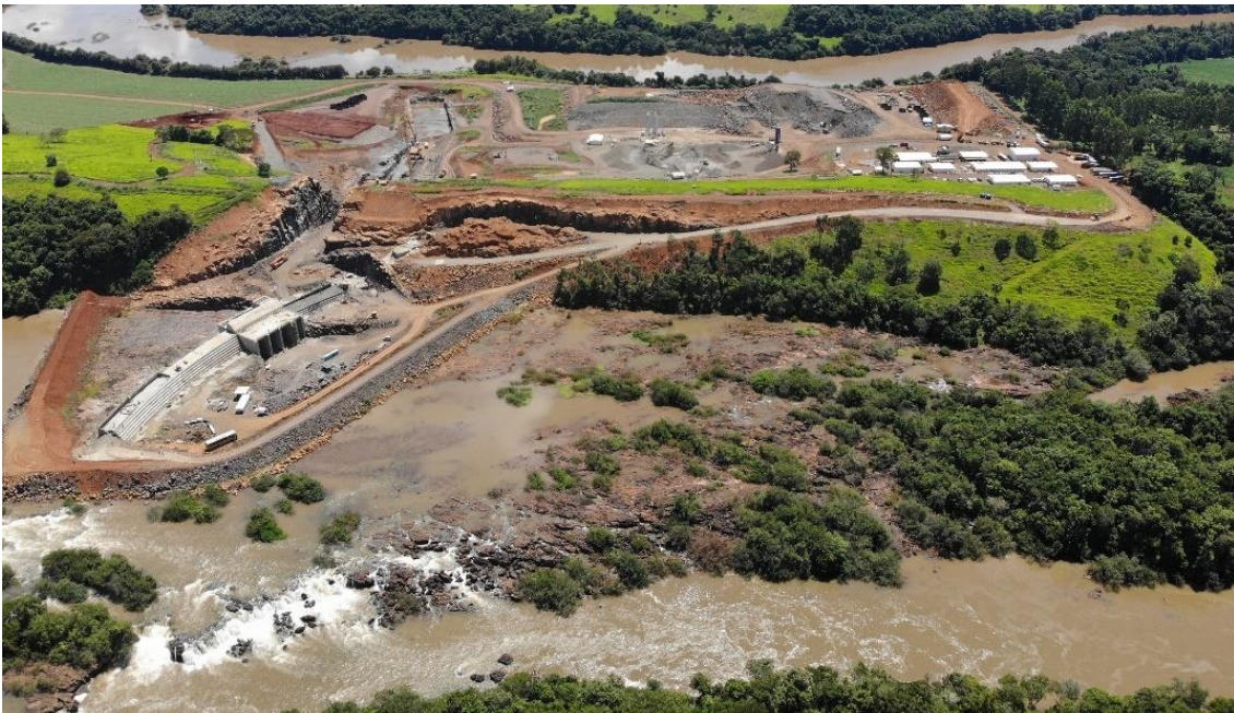
Figura 6-4 – Vista aérea em 04/03/2020 do canteiro de obras da PCH Bela Vista, com afloramentos rochosos e corredeiras expostas no leito do rio Chopim, a jusante da barragem.
