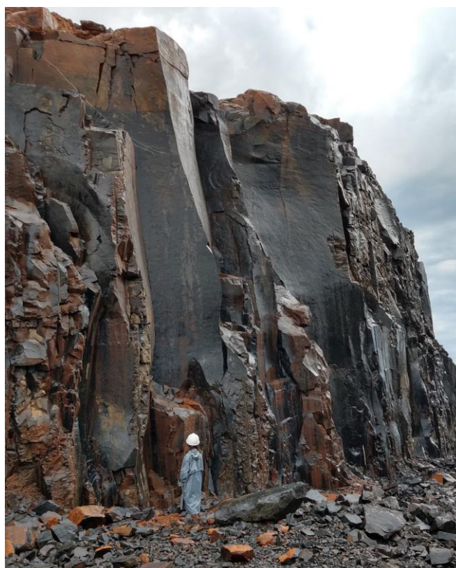
Figura 6-7: Detalhe das paredes escavadas para o Canal de Adução, mostrando as juntas lisas sigmoidais em porção do derrame basáltico tabular (Nov.2019).
