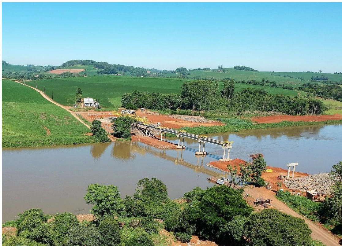
Figura 6-118 - Construção da ponte no local onde funciona a balsa (dezembro de 2020).
