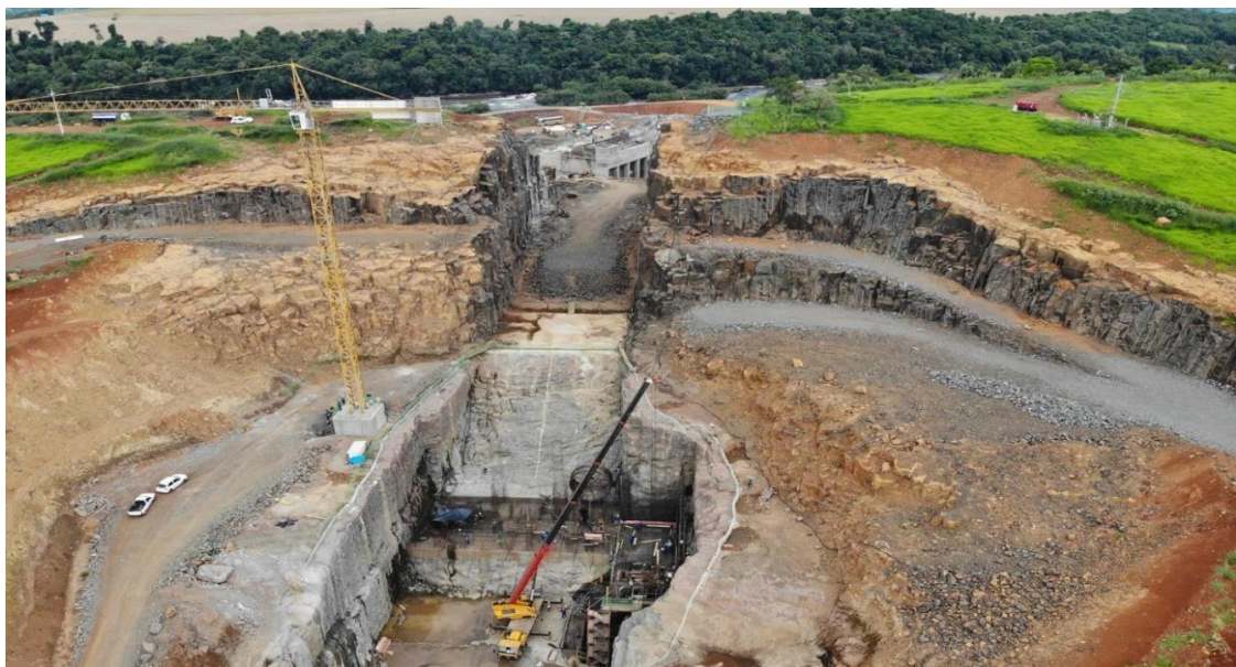
Figura 6-5 – Vista aérea em 12 de fevereiro de 2020, ilustrando os basaltos colunares e sigmoidais no qual está sendo implantado o circuito de geração da PCH Bela Vista.
